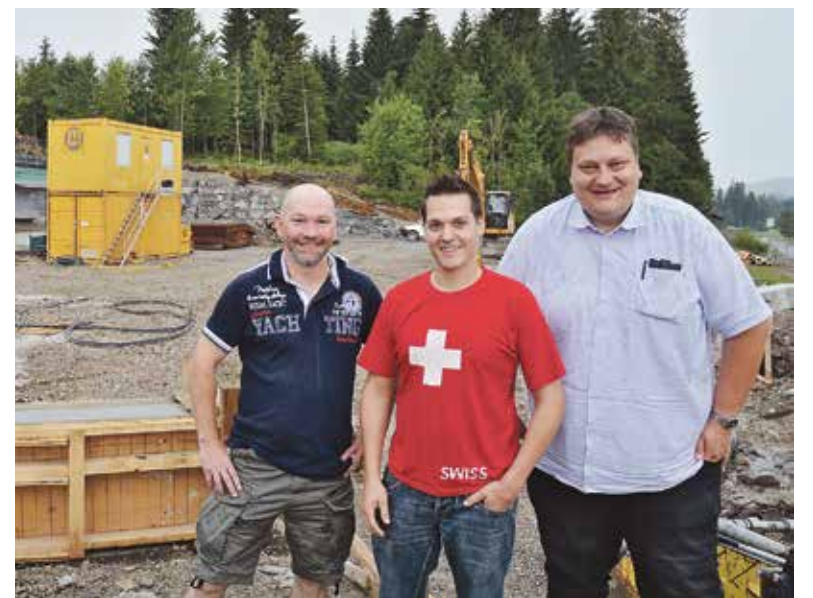
Die Baustelle für die neue Eisbahn ist auf Kurs. Peter Oesch, Präsident des EHC Oberlangenegg sowie Hans Tschanz und Samuel Krähenbühl (v.l.n.r.) von der 3H44 AG als Betreiber, sind zuversichtlich, dass Ende September unter einem Dach neues Eis entstehen wird.
